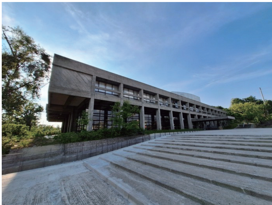
写真3 旧上野市庁舎 SAKAKURA BASE（三重県伊賀市）
