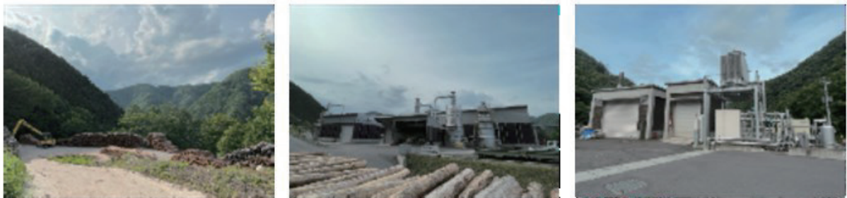
写真1 左から、上野村の山林と低質木材置場、木質ペレット工場、木質バイオマス発電所装置
