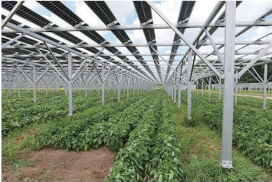
写真2 営農型太陽光発電施設（ソーラーシェアリング）
