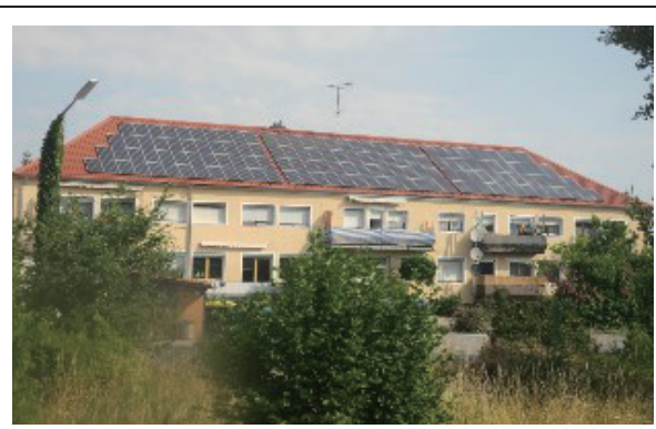
写真2 屋根面積が広い建物に設置される建物PV ／275. Passauの郊外の様子
