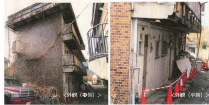
建物の傷みが著しく外壁の剥落、鉄骨の露出などが見られる事例
