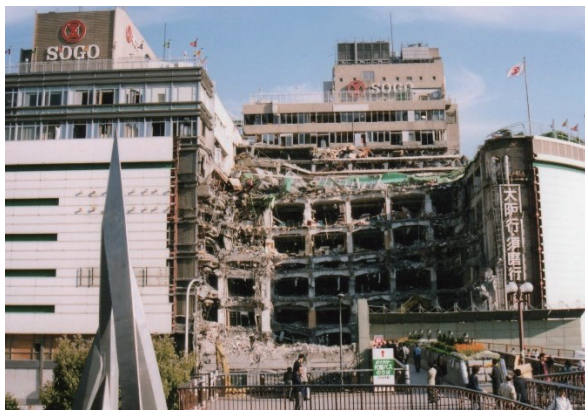
写真1：阪神・淡路大震災による建物被害
