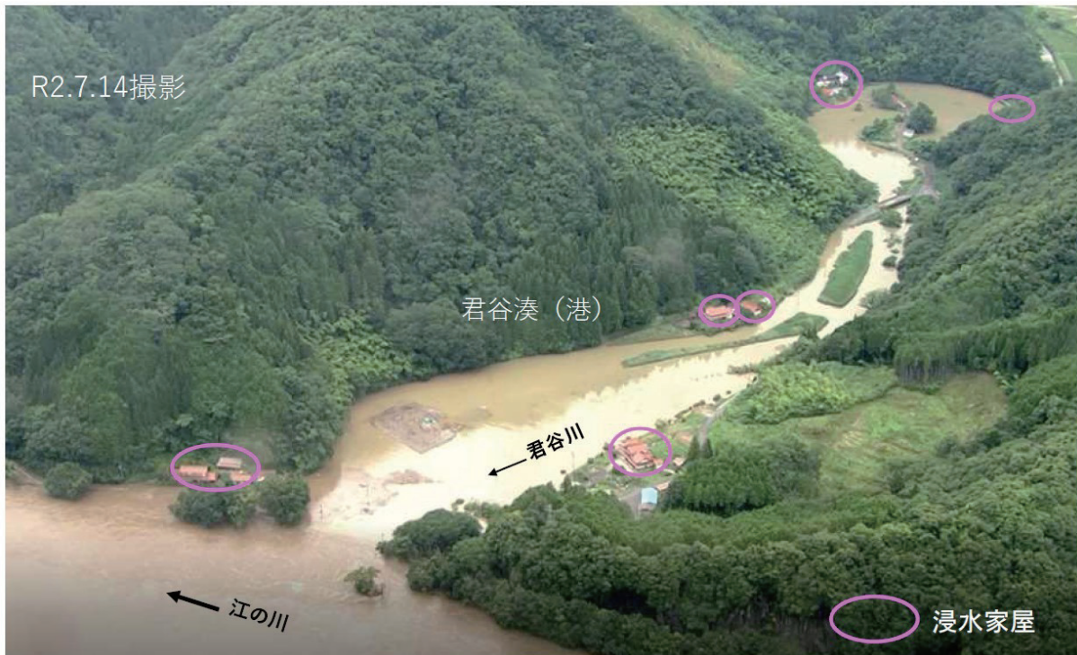
図-10 令和2年7月出水による君谷湊（港）地区の状況
