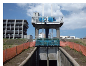
〈樋管ゲート写真〉
