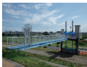
〈樋管全景写真〉
