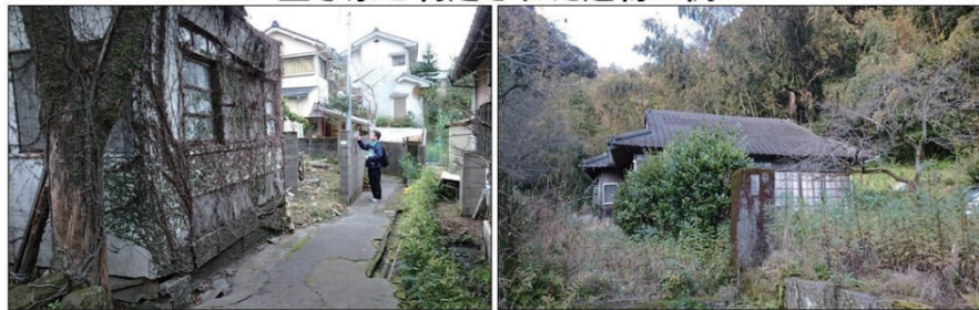
図5 現地調査の様子と空き家と判定された建物の例（いずれも鹿児島市）
