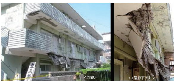
マンションの2階廊下部分が崩落した事例
