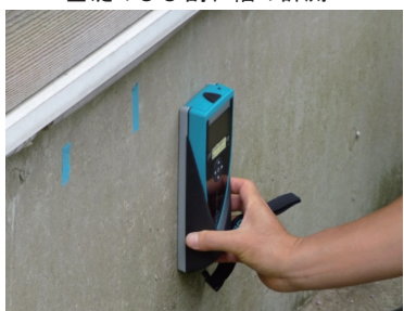
基礎配筋の調査
