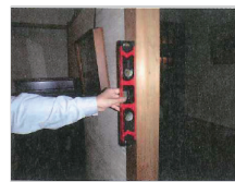
水平器による柱の傾きの計測
