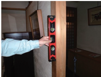
水平器による柱の傾きの計測
