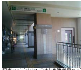
駅南口ヘテスティアンデッキと身障者用エレベーター
