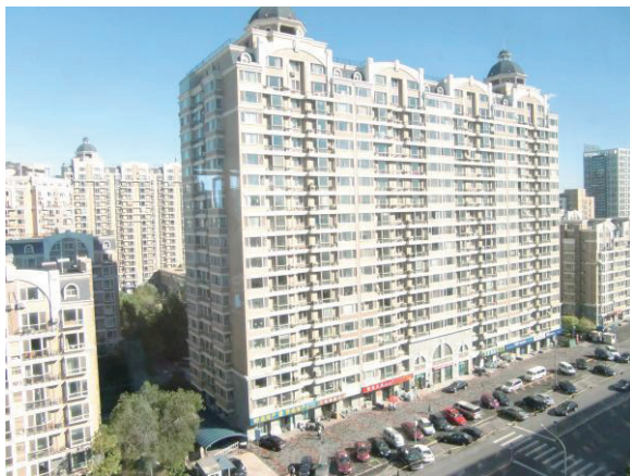
写真1. 北京市崇文区の高層マンション
