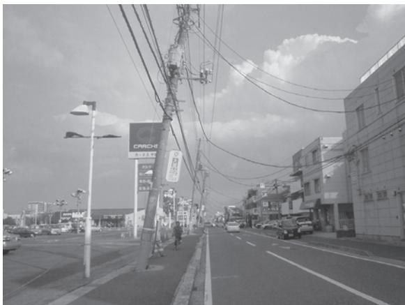
殊に東京都に隣接する浦安市では市域全体の実に 75%に及ぶ面積が液状化し、噴砂により多くの道路や宅地が破壊された。
