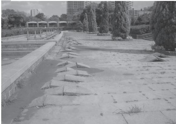
写真 2. 傾き歩道に埋没した電柱
