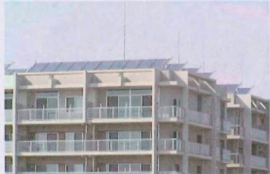
環境モデル街区の太陽光温熱パネル
