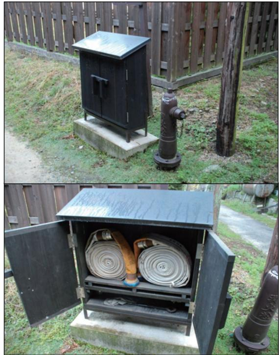
妻籠の住民用消火栓<sup>17</sup>（貯水槽、ポンプ施設とともに町中に1976～81年にかけて設置。通常屋外消火栓と同じ65ミリホース、屋内消火栓同等の45ミリホース各34基、放水銃4基）
