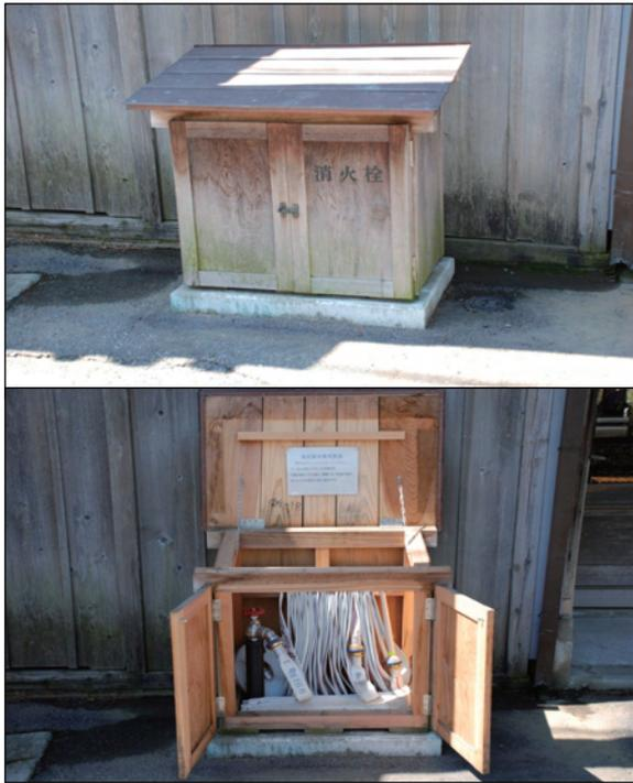
佐原のまちかど消火栓<sup>18</sup>（既存の一般消火栓8基に加え、2002～05年にかけて設置。屋内消火栓で使われる40ミリホース34基のほか、小野川から離れた地区に防火水槽も新設。）
