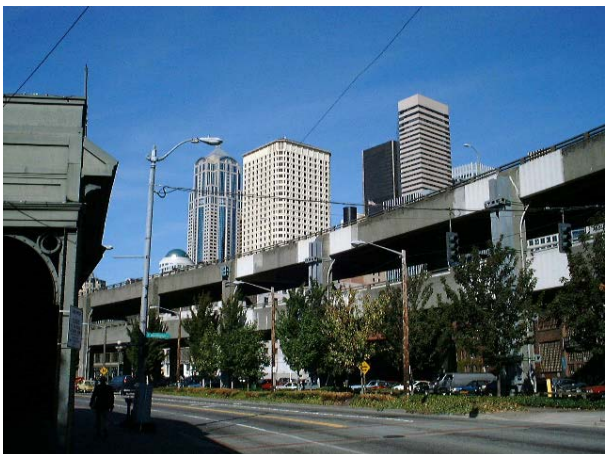
写真12：アラスカン・ウェイ高架道路
