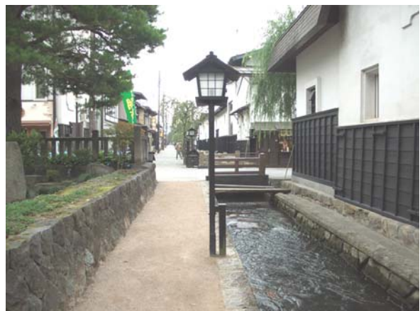
古川 瀬戸川沿いの修景整備 土の道
