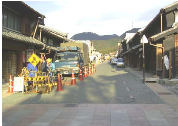
美濃 電線地中化 平成 15年 3月
