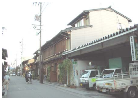
飛騨古川 ○左：3階建てでは2階建てに見えるように。 ×右：修景が無い既存ガレージ。
