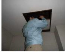
「小室組・梁」調査の様子
