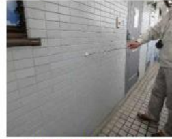
「外部（外壁）」調査の様子
