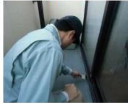
「外部（バルコニー）」調査の様子
