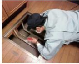
「土台・床組、基礎」調査の様子
