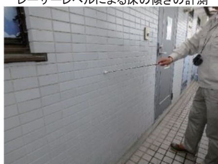
打診棒によるタイルの浮きの調査
