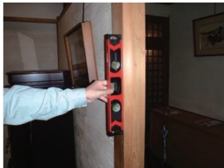
水平器による柱の傾きの計測
