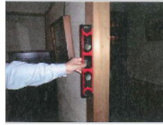
水平器による柱の傾きの計測
