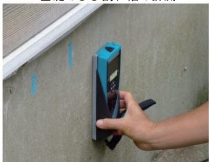
基礎配筋の調査
