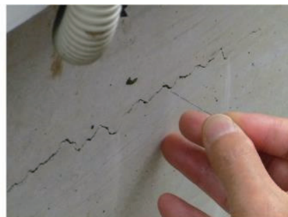
ピアノ線によるひび割れ深さの計測
