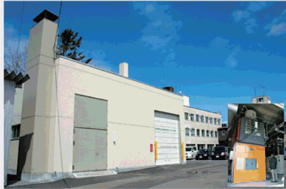
■地域熱供給施設
