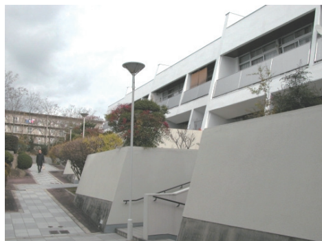
写真-16 消失した建設初期を代表するテラスハウス
