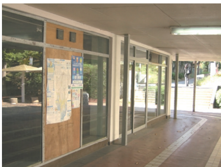
写真-5 空き店舗が並ぶ近隣センター
