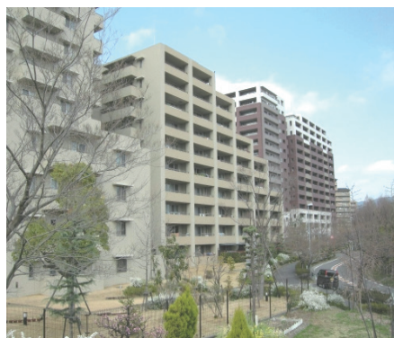
写真-7 建替えられた分譲集合住宅
