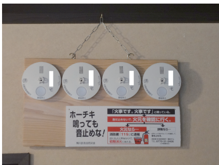
図-14 近隣火災通報システム（福井県若狭町熊川宿）
