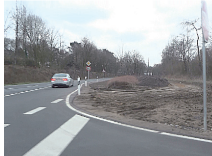
図-12 道路の減築の例(ドイツ・ドルステン市)
